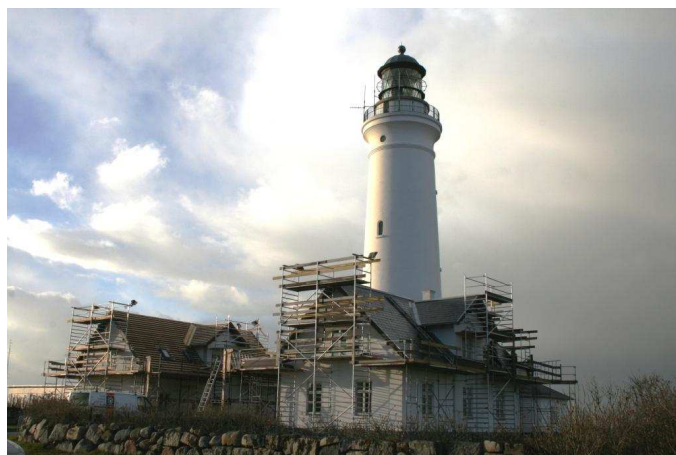
Fyrmesterhuset og assistenthuset skal begge have nyt tag. Den fremtidige tagbeklædning bliver naturskifer. Tagene på bygningerne mellem husene og fyrtårnet renoveres også.
