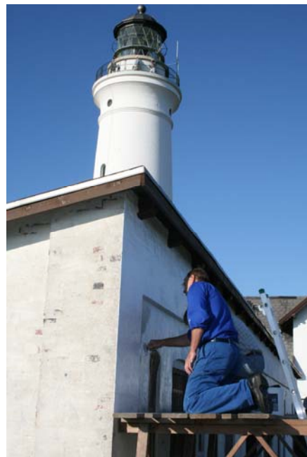
Fyrets Vedligehold var i gang med penslen i de sene sommeraftener, hvor malingen, sponsoreret af Nordsjø Farve, blev smurt på garage og maskinhus.
